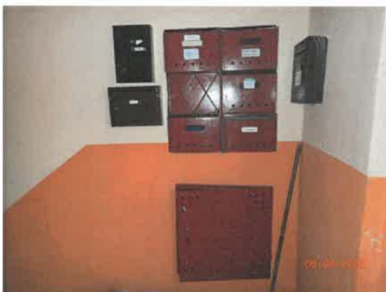
Južná časť bytového domu
