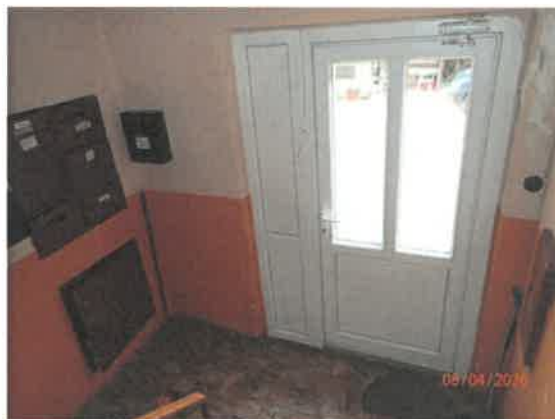
Pohľad na bytový dom zo SZ strany
