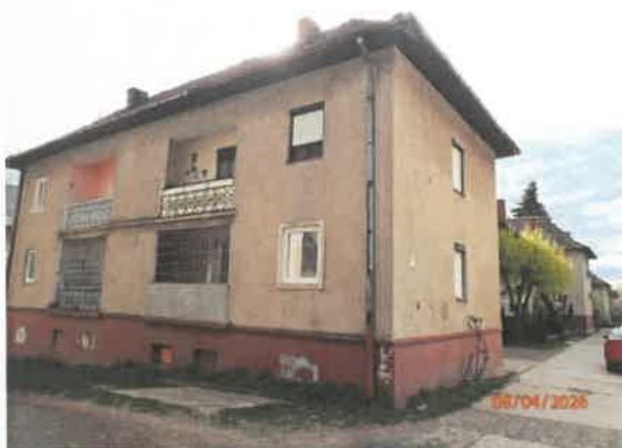
Pohľad na bytový dom zo SZ strany
