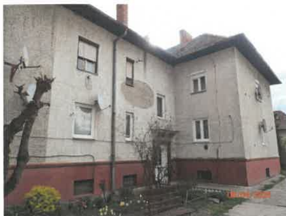
Južná časť bytového domu
