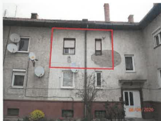
Vchod č. 59 zo západnej strany domu
