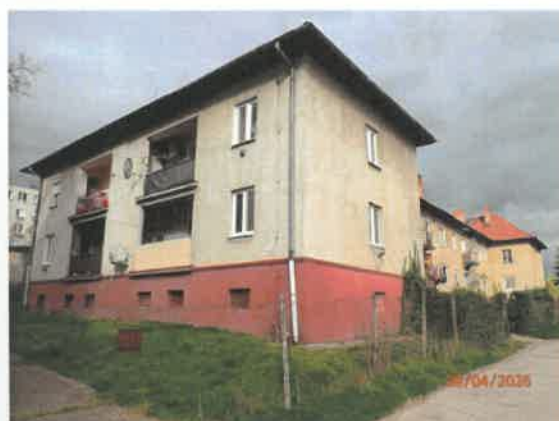
Pohľad na bytový dom zo JV strany
