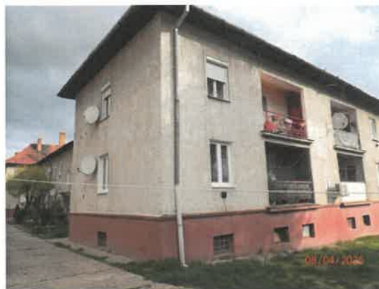
Pohľad na bytový dom z JZ strany
