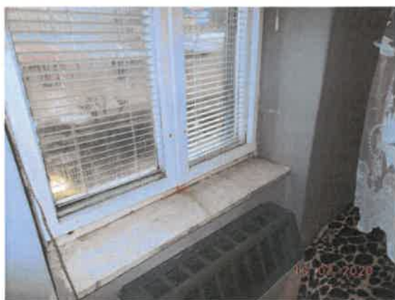
Detail okna izby na západnej strane
