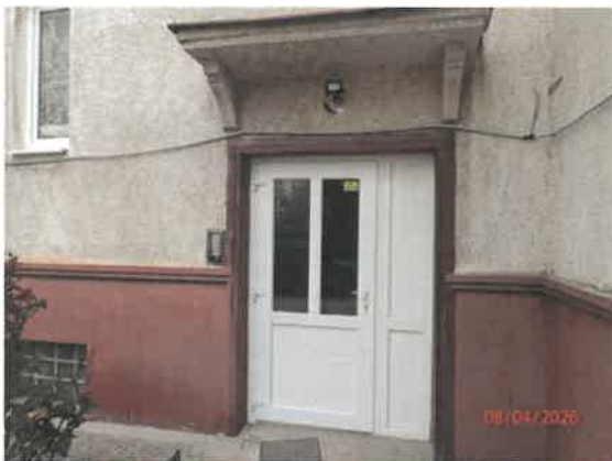
Pohľad na bytový dom zo SZ strany
