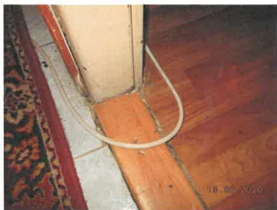
Detail podlahy izby na západnej strane - PVC
