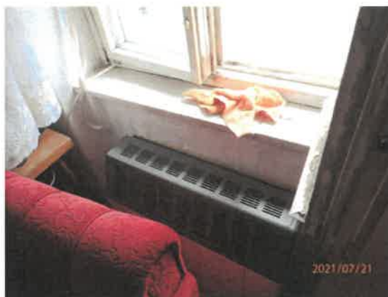
Detail okna a Gamatky izby na východnej strane
