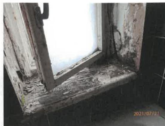
Detail okna v kúpeľni
