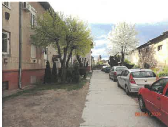
Pohľad na bytový dom zo SZ strany
