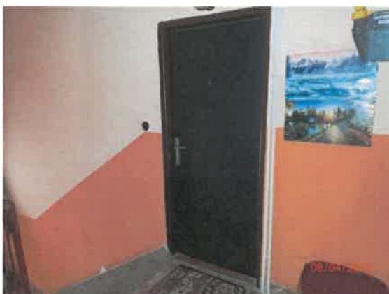
Vchod č. 59 zo západnej strany domu
