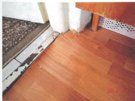
Detail podlahy izby na východnej strane
