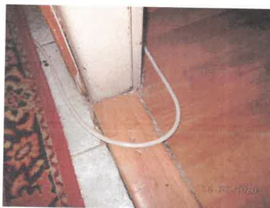
Detail podlahy izby na západnej strane - PVC
