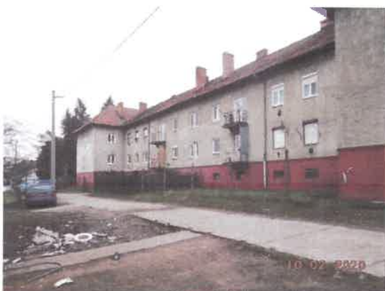
Pohľad na bytový dom zo SV strany
