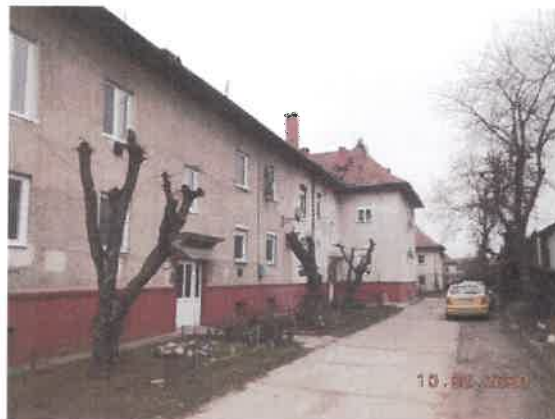
Pohľad na bytový dom zo SZ strany
