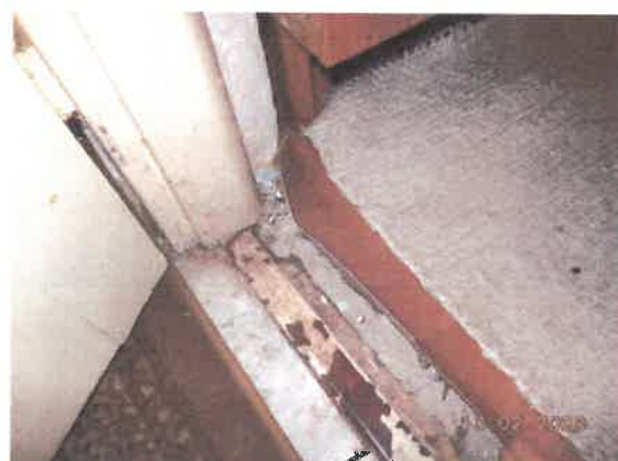
Detail podlahy izby na východnej strane
