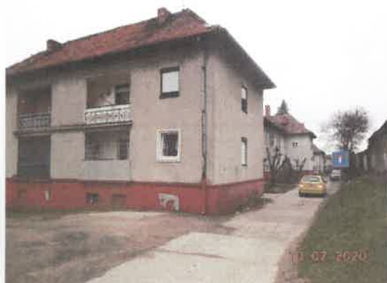
Pohľad na bytový dom zo SZ strany
