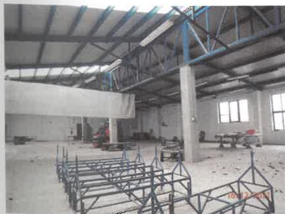
Pohľad do južnej časti skladu
