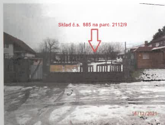
Pohľad na sklad č.s. 865 z ulice
