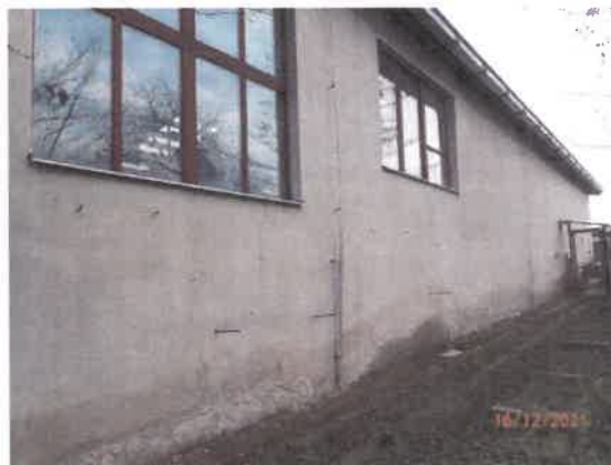
Pohľad na Sklad č.s. 865 z južnej strany
