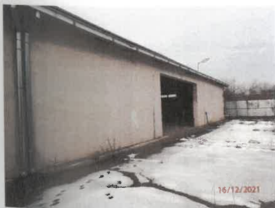
Pohľad na severnú časť skladu
