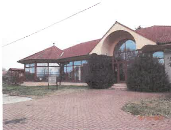
Admin. budova v areáli na parc. 2112/5
