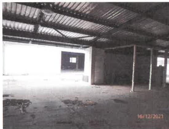
Pohľad z výrobné na dvor
