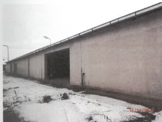
Pohľad na Sklad č.s. 865 zo severnej strany
