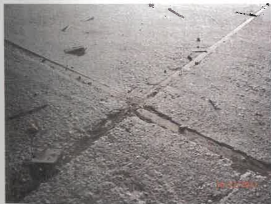
Detail betónovej podlahy výrobné
