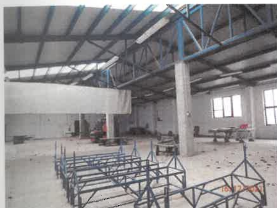
Pohľad do južnej časti skladu
