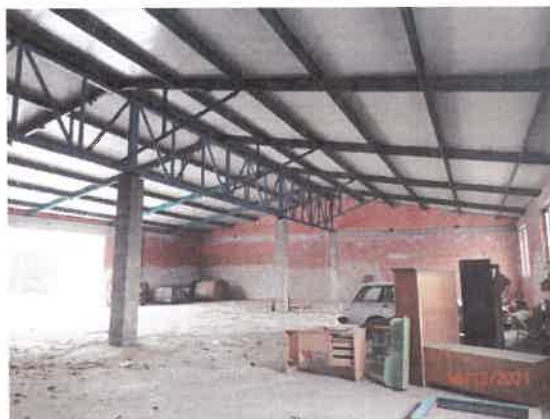
Severná časť skladu bez omietok
