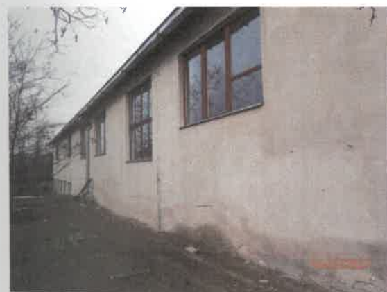
Severná časť skladu z JZ strany
