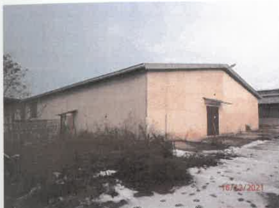
Pohľad na Sklad č.s. 865 z južnej strany
