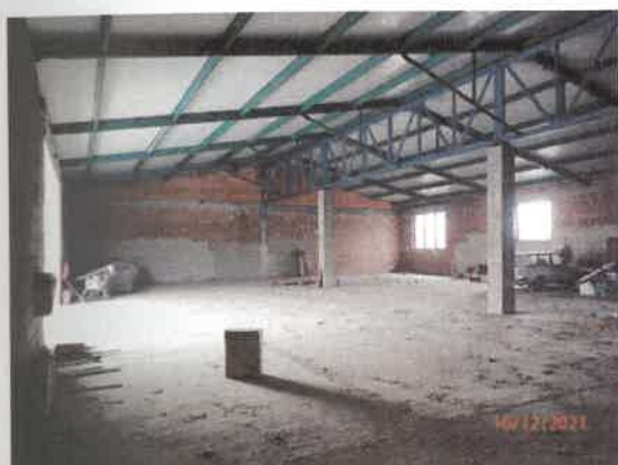
Severná časť skladu bez omietok
