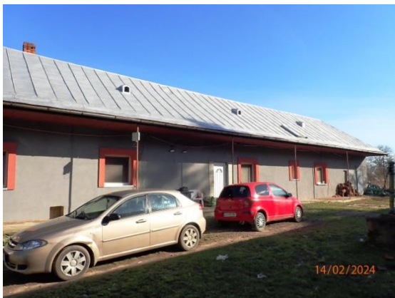
Zadná časť domu z dvora
