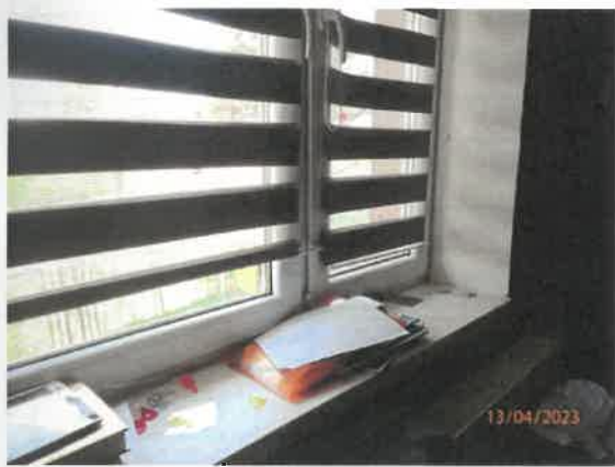
Detail okna prednej izby
