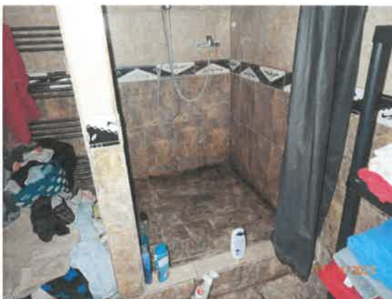
Murovaná sprcha v kúpeľni
