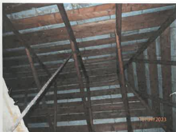
Pohľad na krov domu z garáže
