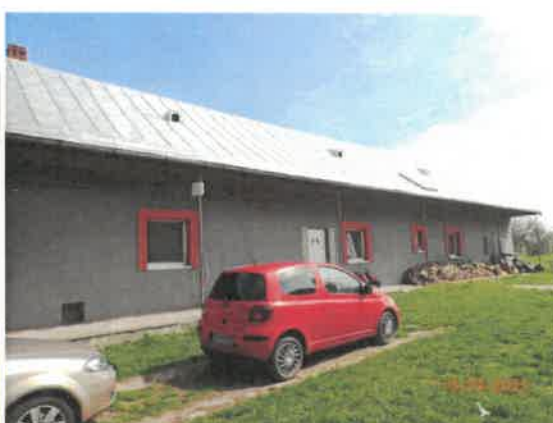
Zadná časť domu z dvora
