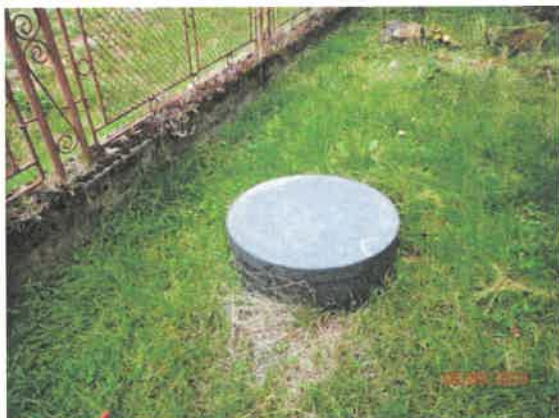
Vodomerňá šachta pred domom
