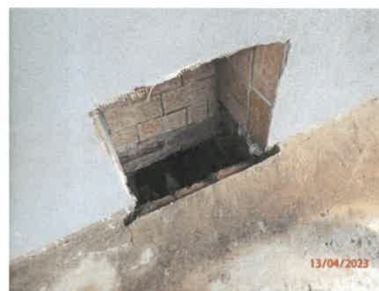
Vetrák nedostupnej pivnice pod domom
