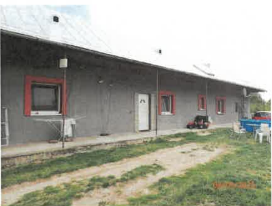
Zadná časť domu z dvora
