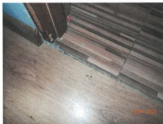
Detail podlahy zadnej izby-plávajúca laminátová
