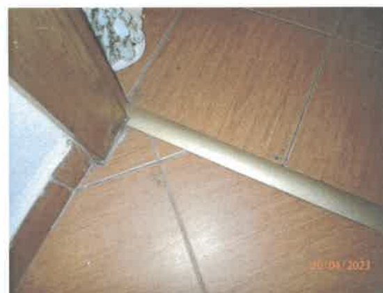
Detail podlahy sklad – chodba v suteréne
