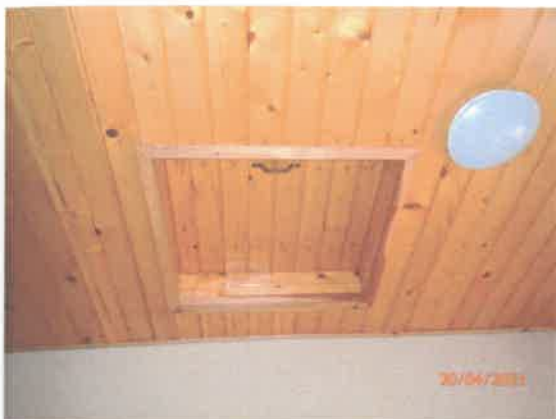
Strop skladu garáže
