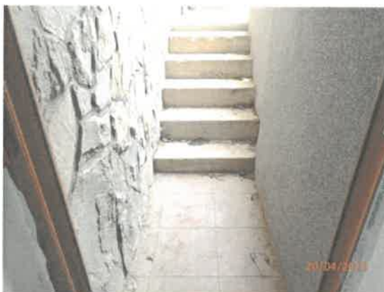
Schody do suterénu prístavby domu
