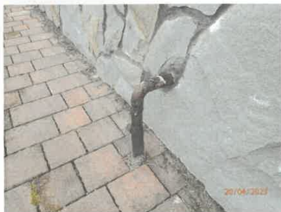
Zaústenie prípojky plynu pri dome
