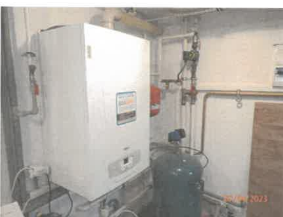
Kotel ÚK s ohrevom TUV v suteréne
