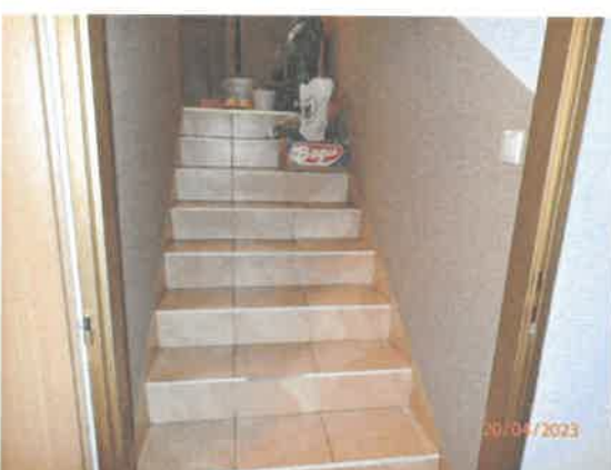
Schody v dome do suterénu
