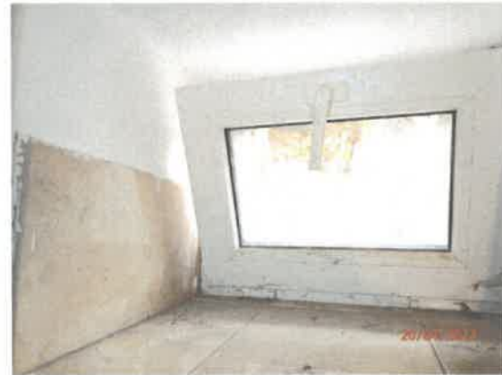
Detail okna skladu v suteréne
