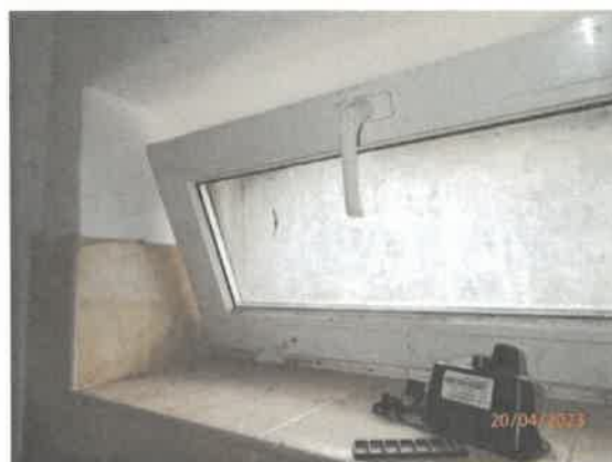
Detail okna práčovne v suteréne
