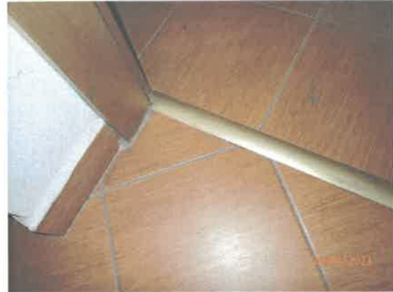
Detail podlahy sklad – chodba v suteréne
