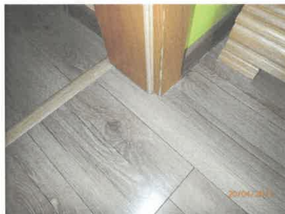
Detail podlahy izby v podkroví
