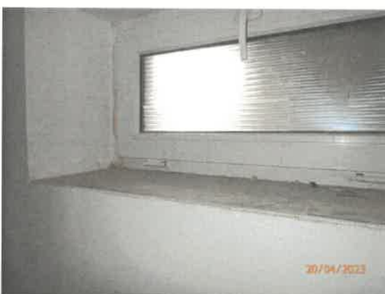
Detail okna skladu v suteréne
