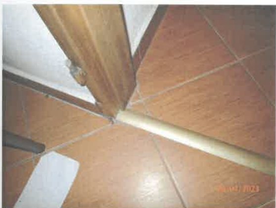
Detail podlahy sklad – chodba v suteréne
