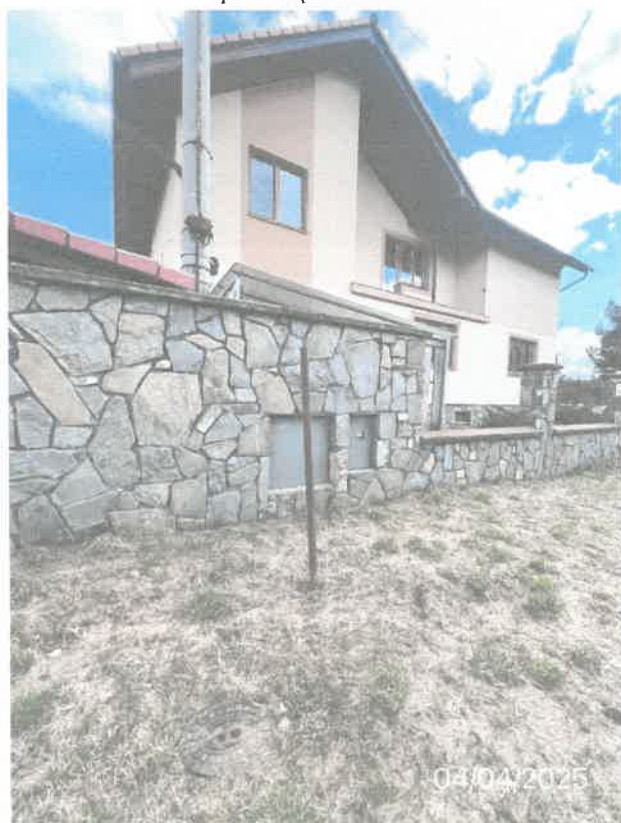
revízne skrinky prípojok v oplotení
