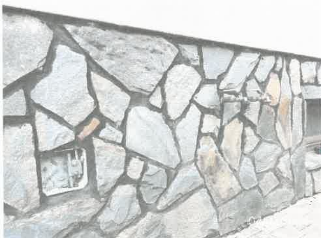
obklad stien suterénu po obvode domu
