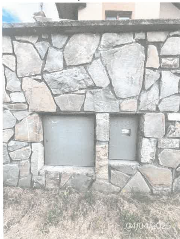
revízne skrinky prípojok v oplotení
