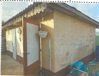
Drobná stavba- sklad na p. č. 1335/1
