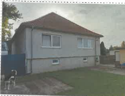
Pohľad z dvora- severozápadný
