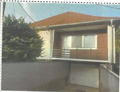
Pohľad od ulice- juhovýchodný
