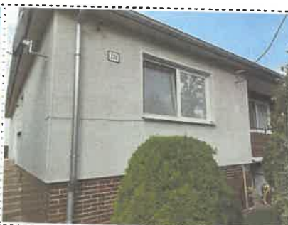
Pohľad od ulice- juhovýchodný
