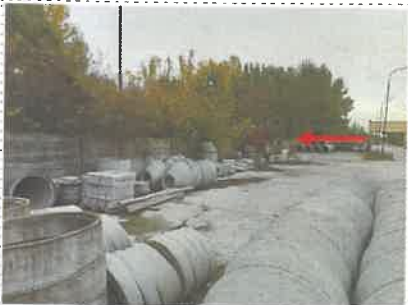
Pohľad na prístup k p. č. 3539/62
