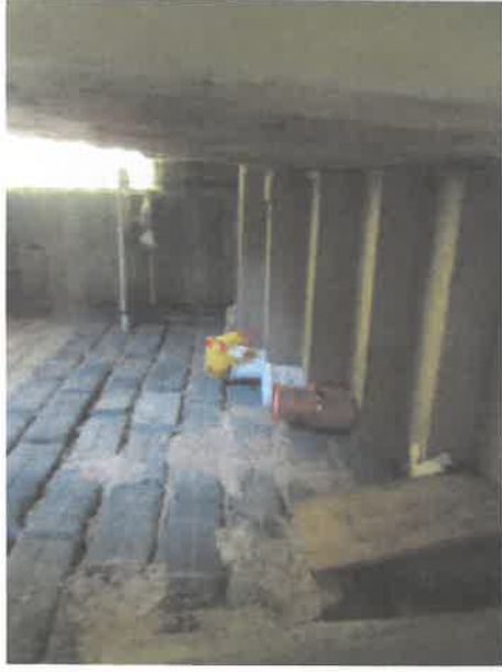
Schody na II.NP
