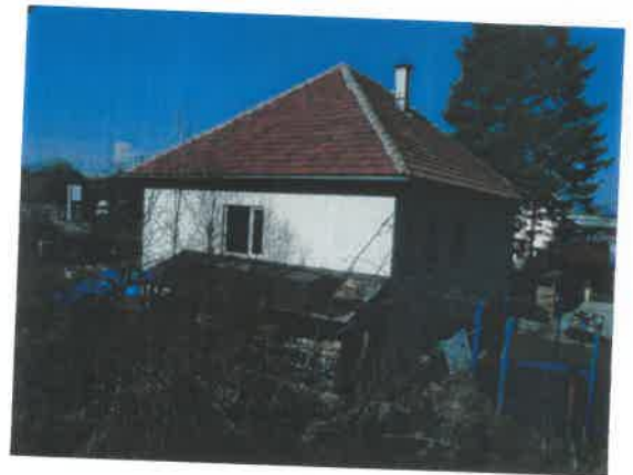
Rod. dom s.č. 293 – pohľad severovýchodný
