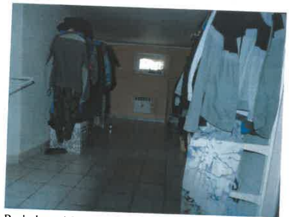
Rod. dom, 1 NP – chodba
