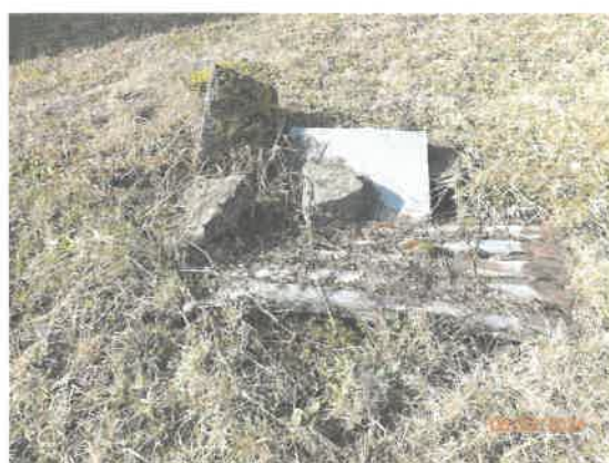
Stará poškodená studňa na pozemku
