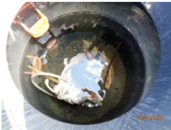
Pohľad do šachty nad studňou na parc. 216/1
