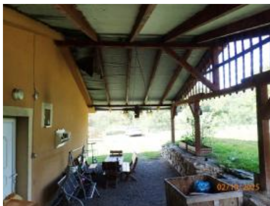
Prístrešok na severnej strane domu
