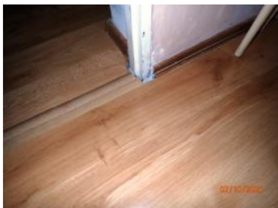
Detail podlahy izby 1.06
