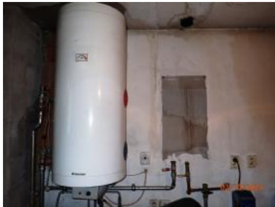
Ohrievač TÚV a demotovaný plynový kotol ÚK
