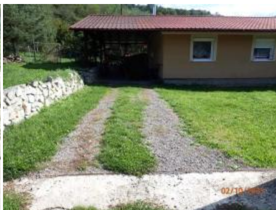
Vchod do dvora z ulice na par. 216/1
