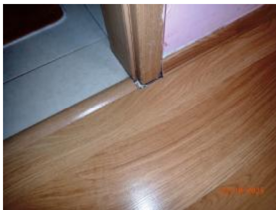
Detail podlahy izby 1.08
