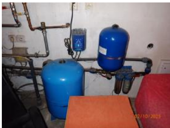
Tlaková nádoba domácej vodárne v kotolni
