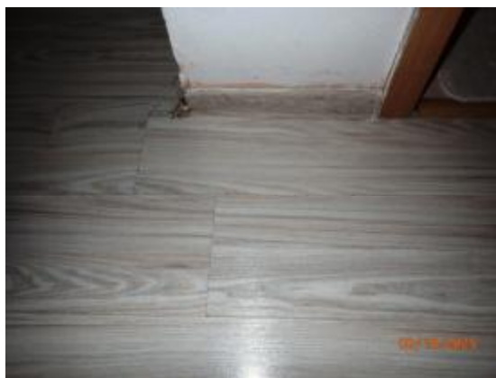
Detail podlahy izby 1.07
