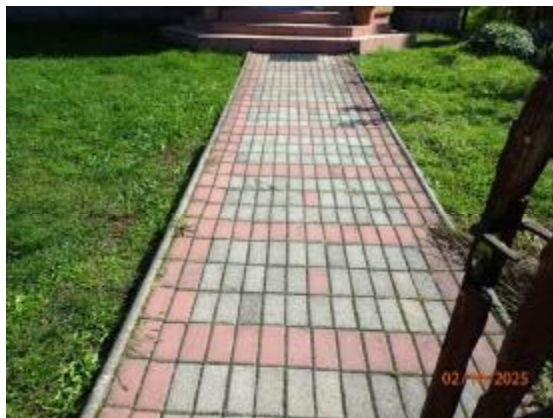
Vstupný chodník do domu na parc. 216/1
