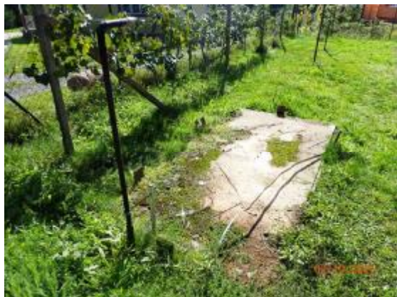
Základ plynovej nádrže za domom
