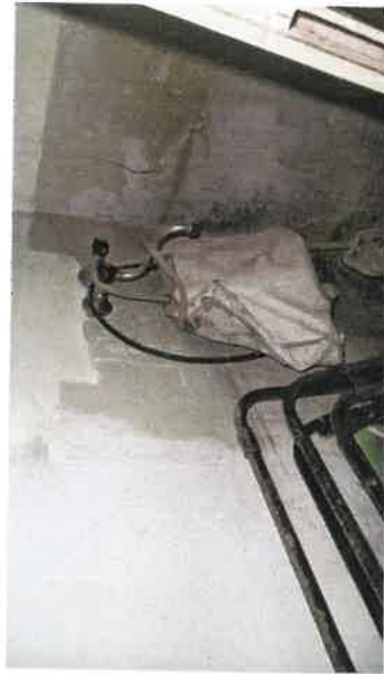
Pohľad na podlahu v ob. izbe
