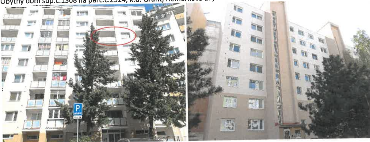
Byt č.17/6.poschodie – predsieň, kuchyňa, kúpeľňa
