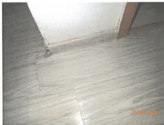
Detail podlahy izby 1.07
