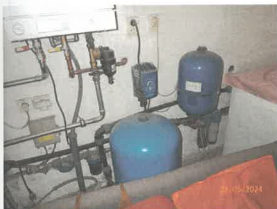
Tlaková nádoba domácej vodárne v kotolni
