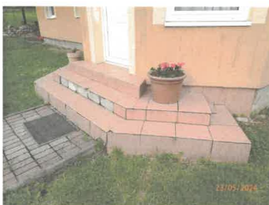
Vonkajšie schody do domu z dvora
