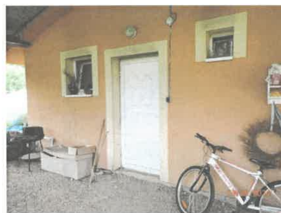
Vchod do technickej miestnosti domu
