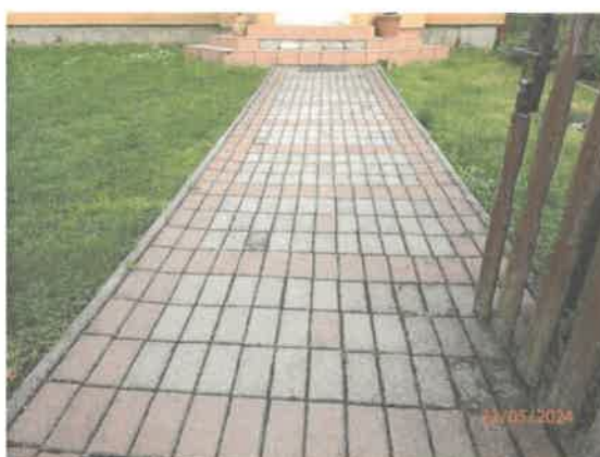
Vstupný chodník do domu na parc. 216/1
