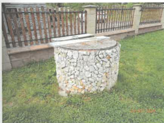
Nefunkčná studňa pri dome na parc. 216/1
