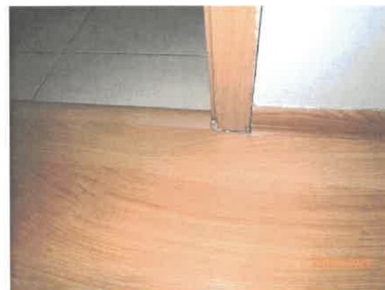
Detail podlahy izby 1.08
