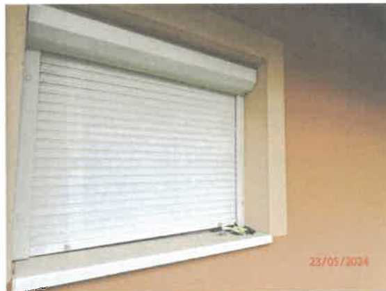
Okno izby na východnej strane z vonkajšej strany
