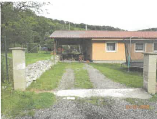
Vchod do dvora z ulice na par. 216/1
