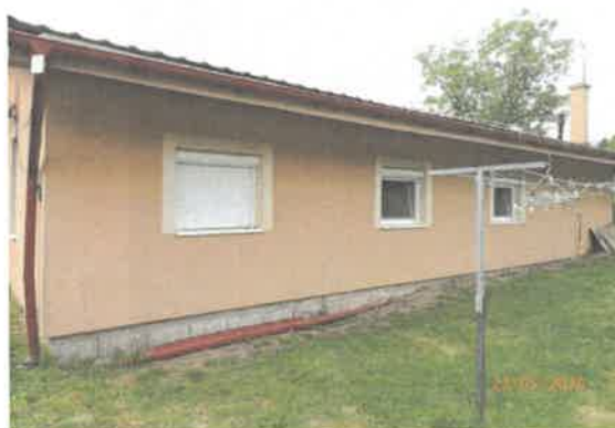
Východná strana domu
