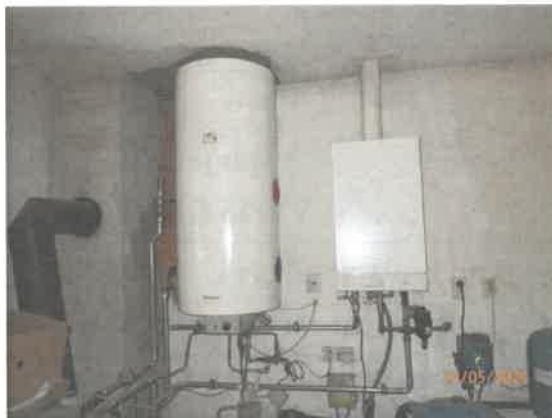
Plynový kotel ÚK a ohrievač TUV
