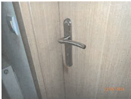
Detail dverí v dome
