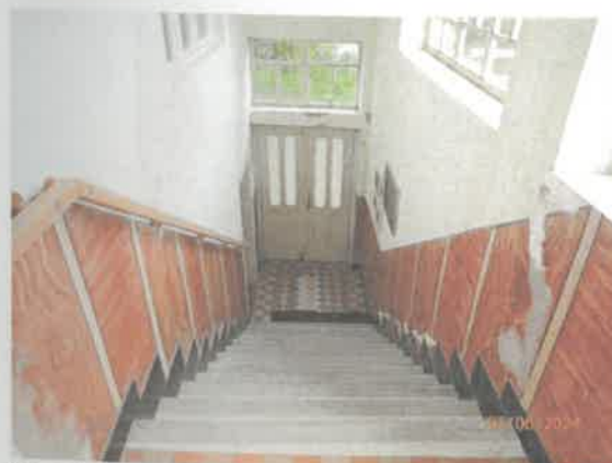
Schodisko na II.NP
