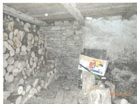
Pohľad do murovanej časti drevárne
