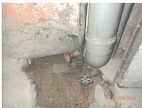
Prívod vody do domu na I.NP
