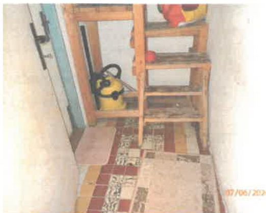
Schody na povalu na II.NP
