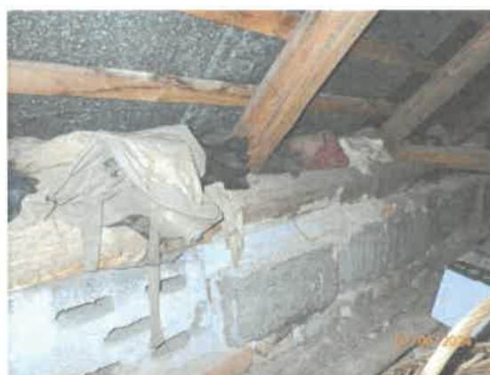
Detail podmurovky a pomúrnice na povale
