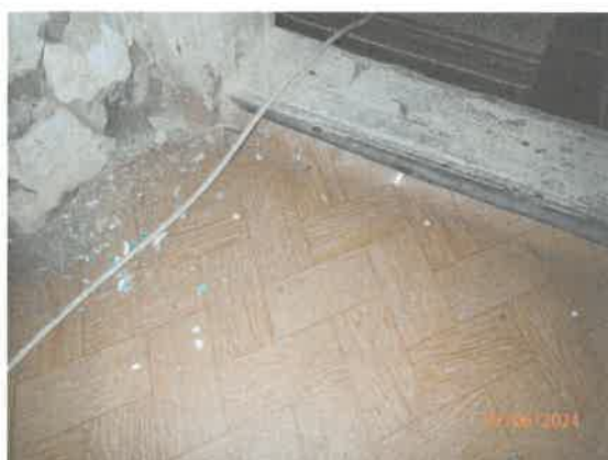
Detail podlahy skladu na I.NP - PVC
