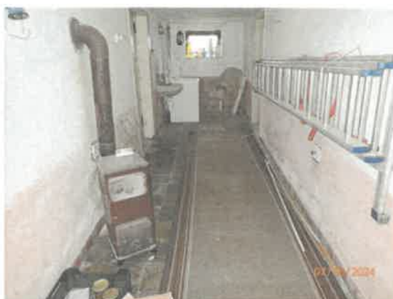
Chodba na I.NP
