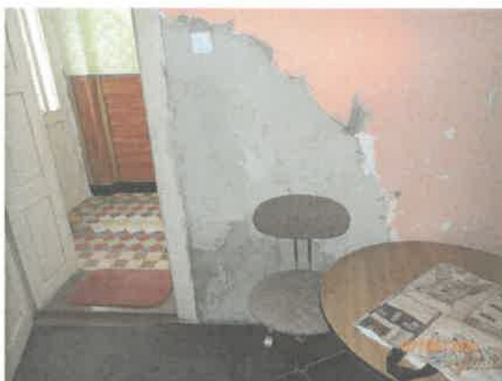
Opravované poškodené steny na I.NP
