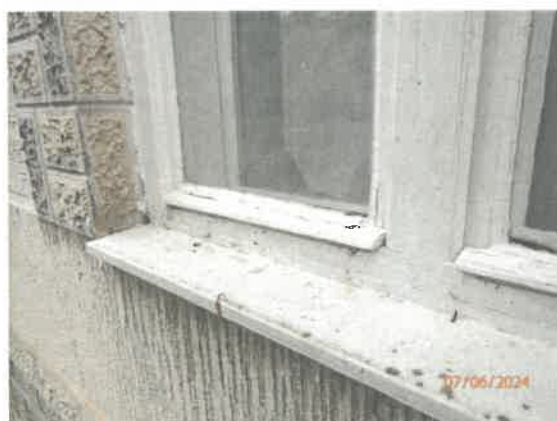
Detail okien domu z vonkajšej strany
