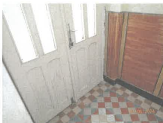
Vstup do domu od ulice na I.NP
