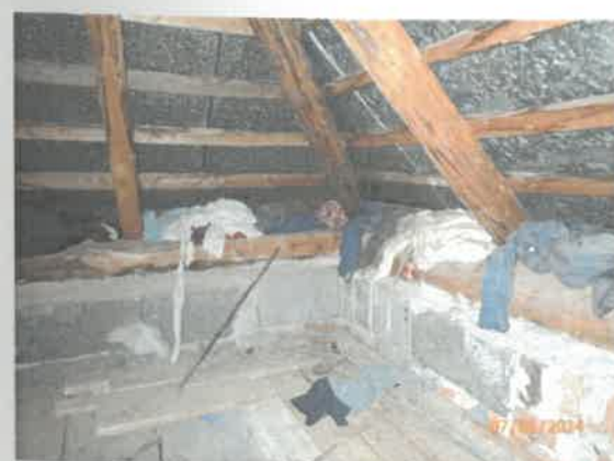
Detail podmurovky a pomúrnice na povale
