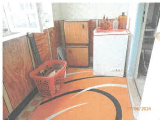
Schodisko na II.NP
