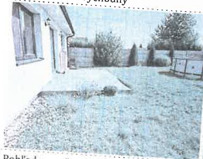
Pohľad na p. č. 2135/2- terasa
