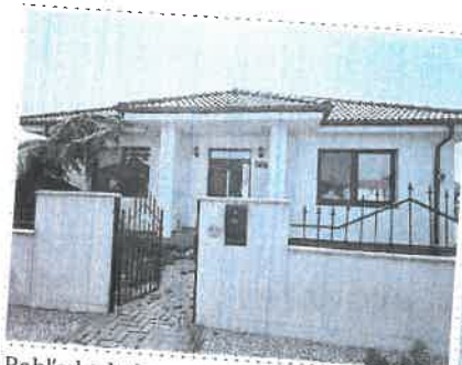
Pohľad od ulice- severozápadný
