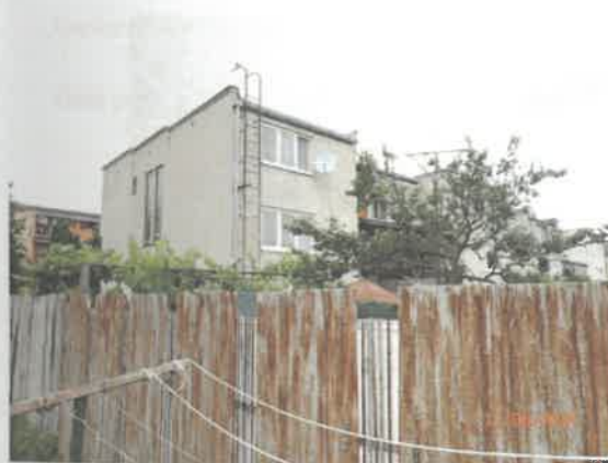
Pohľad na dom z JZ strany
