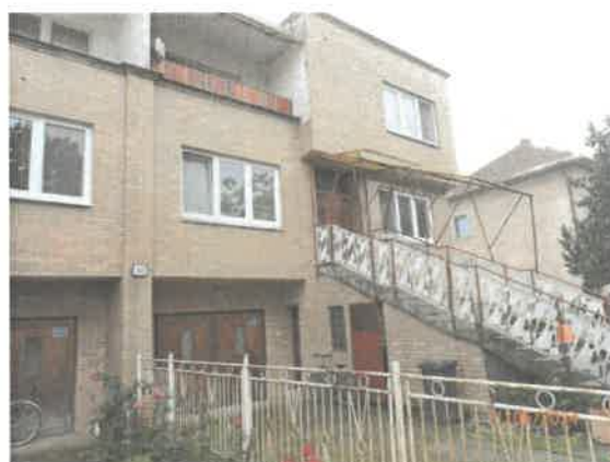
Pohľad na dom zo SV strany od ulice
