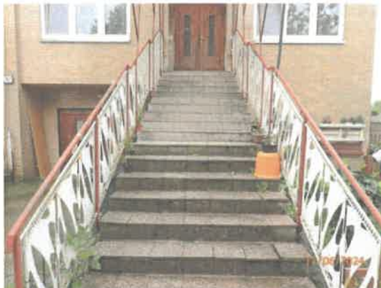
Vonkajšie schody do domu
