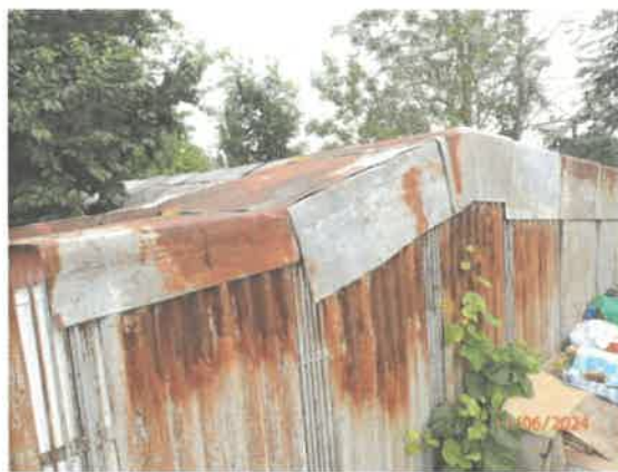
Vedľajšie stavby za domom v zadnej časti dvora
