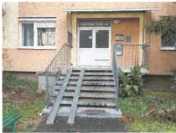
Fotodokumentácia bytu č. 23, 8. NP, vchod 18, v bytovom dome s.č. 1025, na parcele č. 2669, 2670, 2671, 2672, 2673, 2674, 2675, 2676, kú Šaľa
