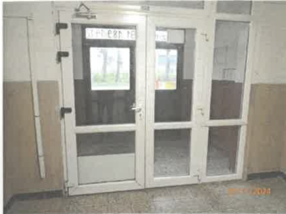
Vstup do spoločnej chodby na I.NP
