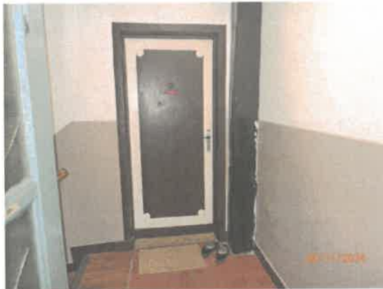
Vstupné dvere do bytu č. 5
