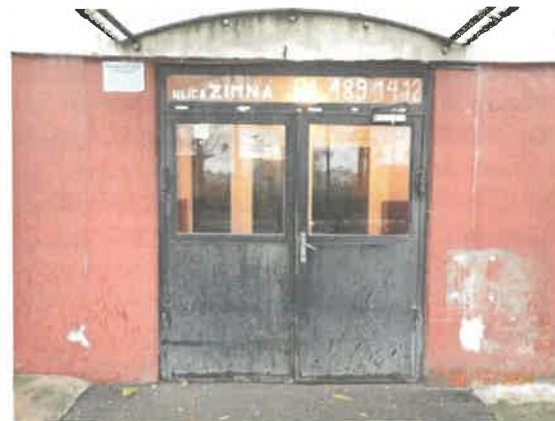
Spoločný vchod č. 12 a 14 z východnej strany
