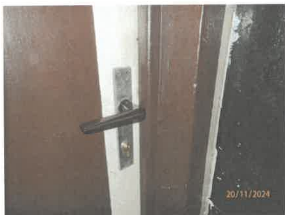
Detail vstupných dverí do bytu č. 5
