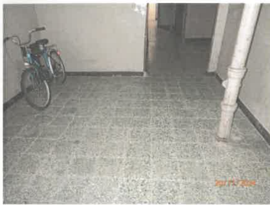
Spoločná chodba na I.NP
