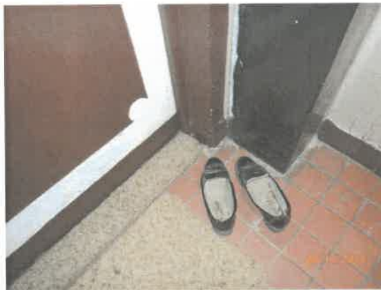
Detail spoločnej chodby pred bytom č. 5
