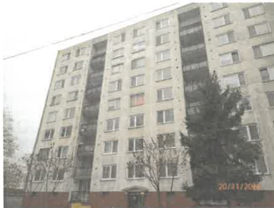
Pohľad na bytový dom zo SV strany
