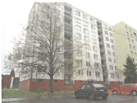
Pohľad na bytový dom z JV strany
