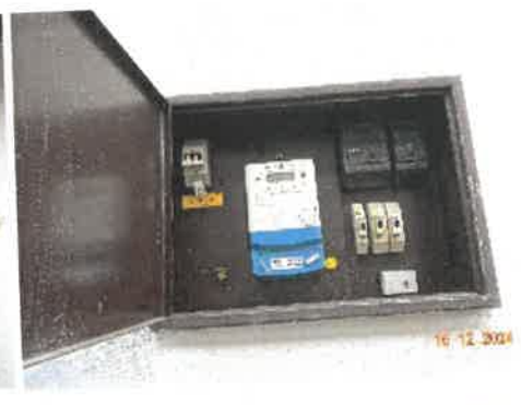
Zadná časť domu, vzdušná prípojka na elektrinu a domový rozvádzač
