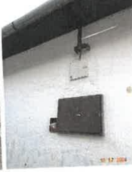
Zadná časť domu, vzdušná prípojka na elektrinu a domový rozvádzač
