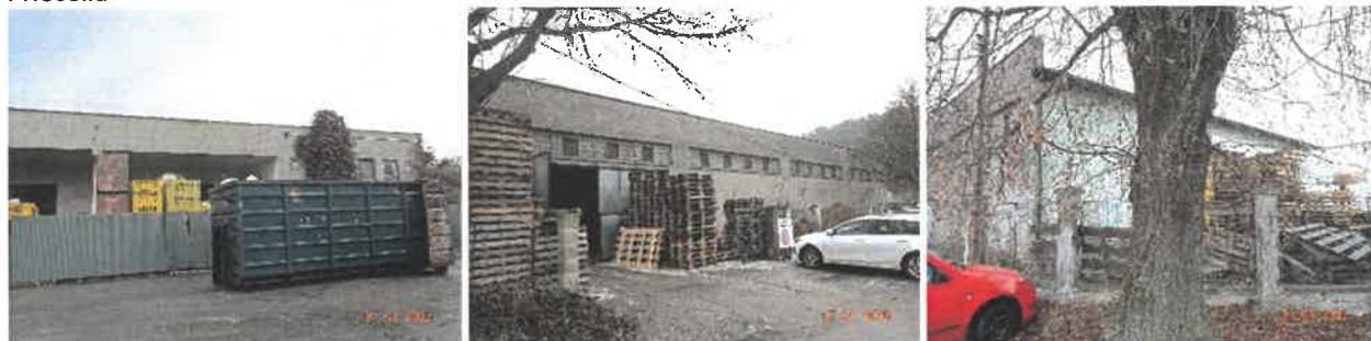
Zastrešená časť a interiér skladovej časti
