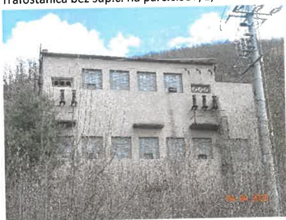
Trafostanica bez súp.č. na parc.č.957/2, Rakovnica
