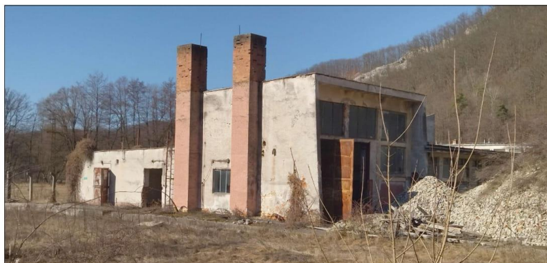
bočná JV a čelná SV fasáda s vjazdmi do garáží
