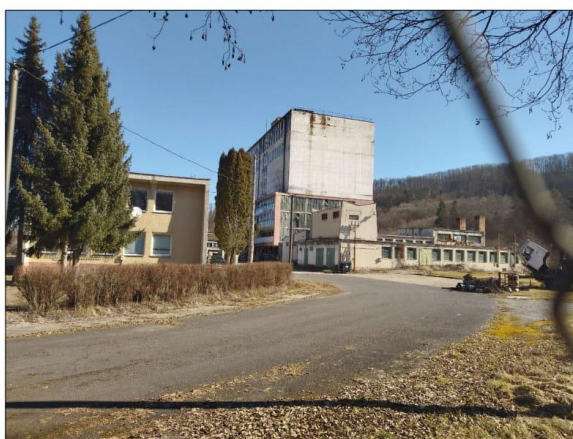
vstupný priestor areálu za hlavnou bránou
