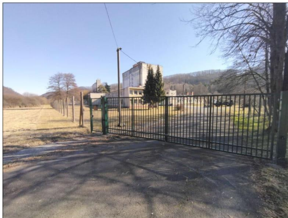
hlavný vstup do areálu (od cesty I/66)
