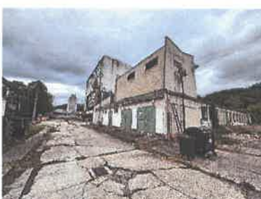
Pohľad zo dvora – trafostanica a skladové priestory
