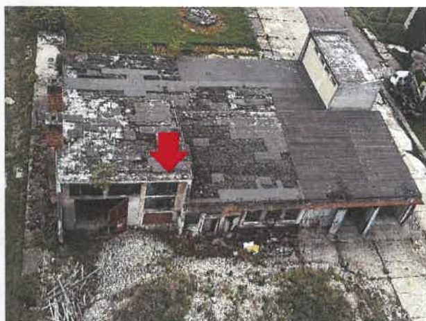
Obr.č.5 : Fotodokumentácia – pohľad zhora – aktuálny stav objektu s.č. 136
