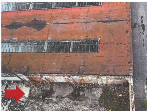
Obr.č.3 : Fotodokumentácia – pohľad zhora – zbúraná časť objektu s.č. 136
