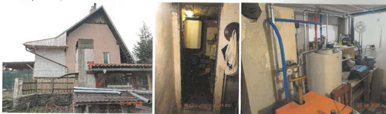
Suterén – domáca vodáreň, kotel, prízemie – pristavaný vstup s rozvádzačom, vstavaná skriňa
