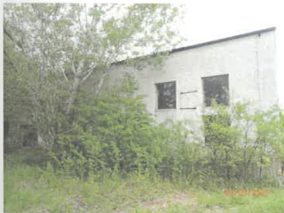
Pohľad na kotolňu zo severnej strany
