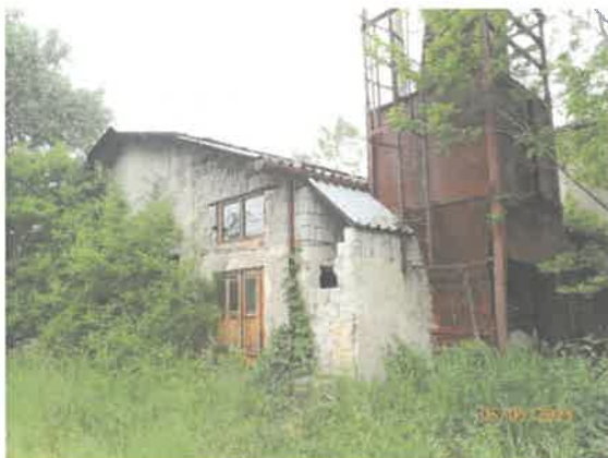
Pohľad na kotolňu z JV strany
