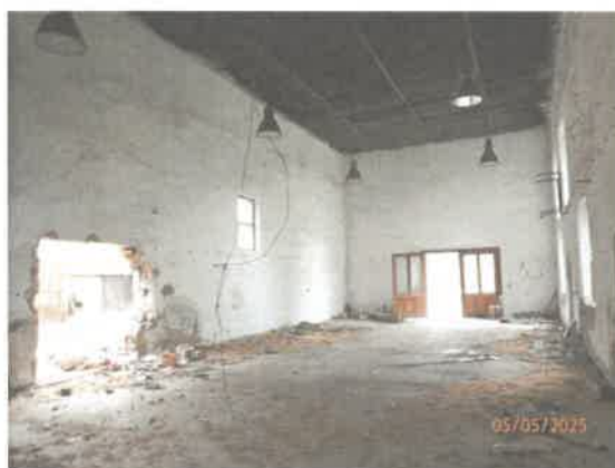
Západná časť kotolne
