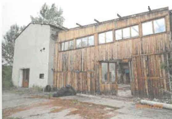
Pohľad na kotolňu z JZ strany
