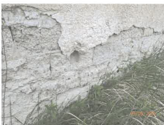
Detail muriva – škvárobetónové tvárnice
