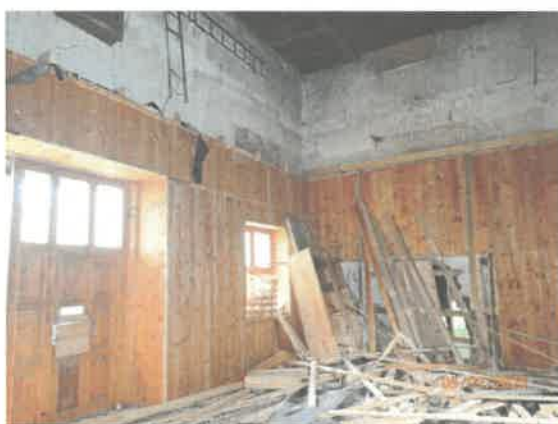
Východná časť kotolne
