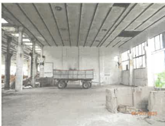
Severná časť haly na východnej strane
