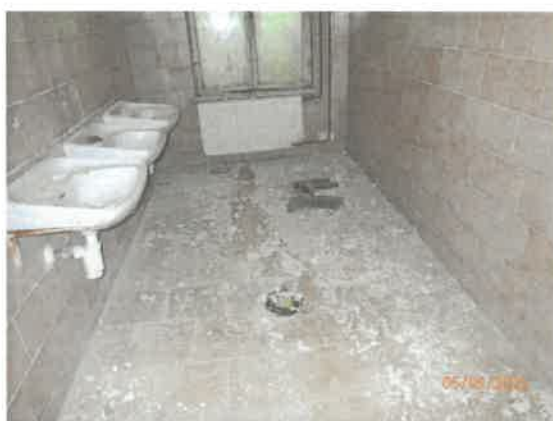
Pohľad do časti stavby
