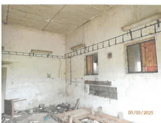
Pohľad do časti stavby
