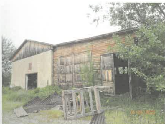
Pohľad na stavbu z JZ strany
