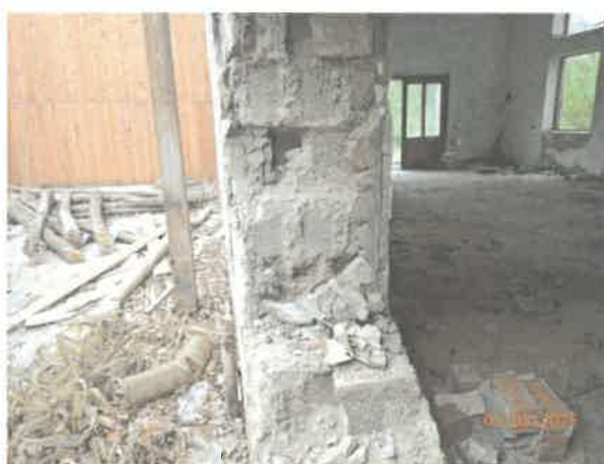
Detail muriva kotolne – škvárobotónové tvárnice
