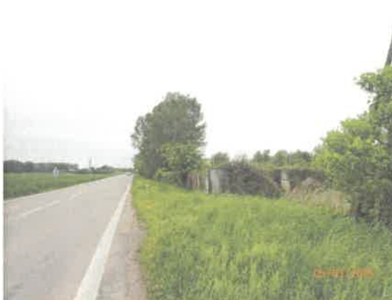
Hlavná cesta I/79 na severnej strane areálu
