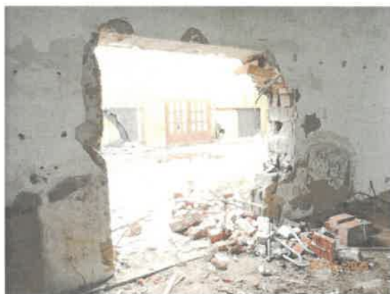
Prechod do prístavby kotolne
