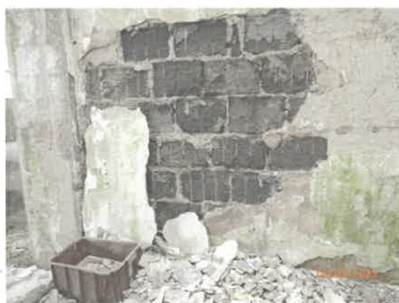
Výplň. murivo z plynosilikátových tvárnic
