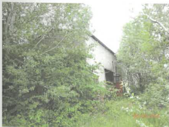
Pohľad na kotolňu zo SV strany
