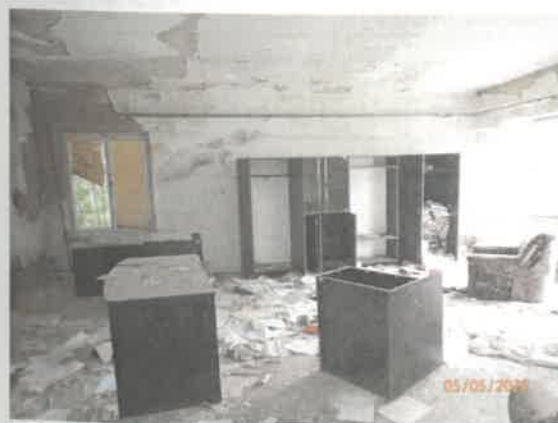
Pohľad do časti stavby
