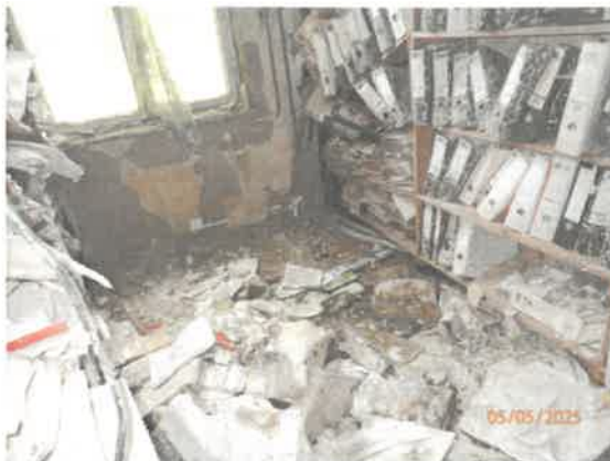
Pohľad do časti stavby
