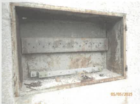
RIS na fasáde kotolne
