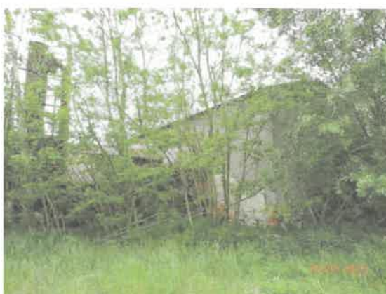
Pohľad na kotolňu z JV strany
