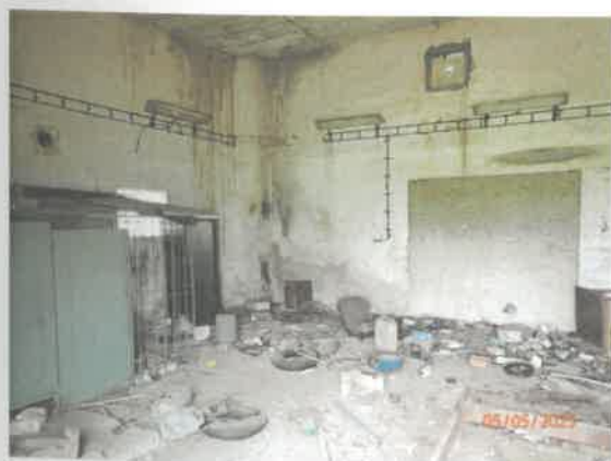
Pohľad do časti stavby
