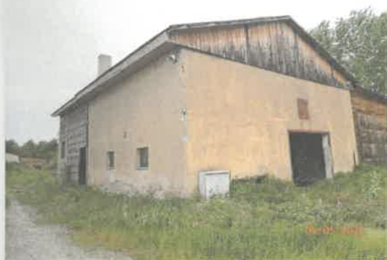
Pohľad na stavbu zo SZ strany
