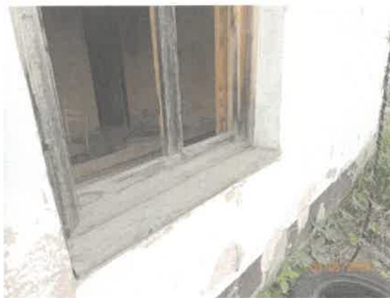
Detail okna strážnice
