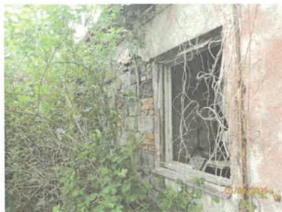
Južná strana stavby
