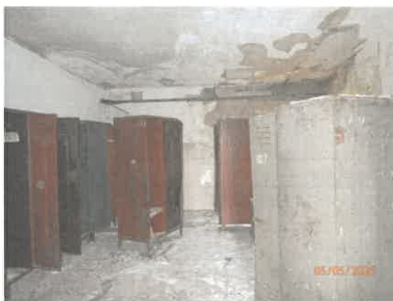
Pohľad do časti stavby
