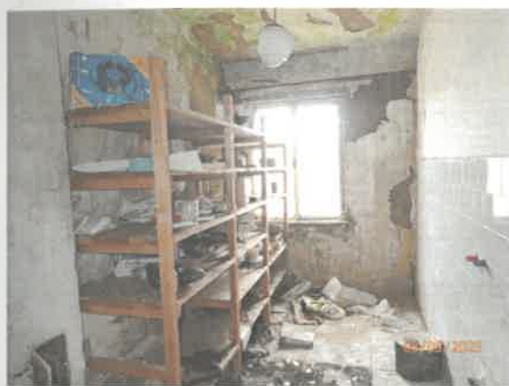
Pohľad do časti stavby
