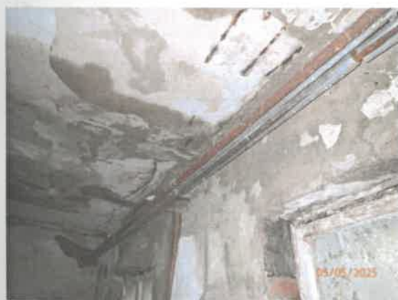
Pohľad do časti stavby
