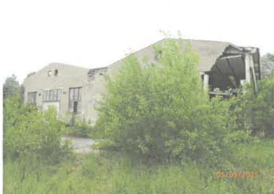
Výr. hala z východnej strany
