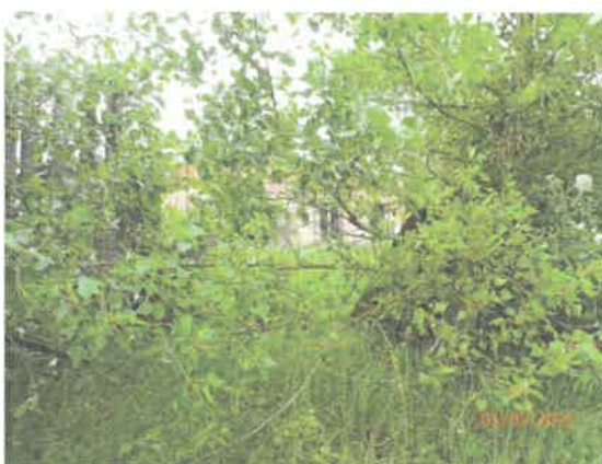
Poškodený plot na západnej strane areálu
