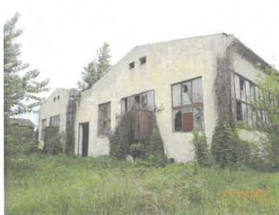
Pohľad na halu z JZ strany
