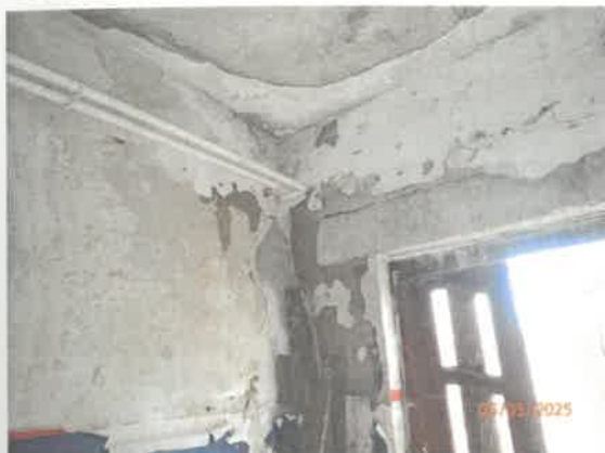
Pohľad do časti stavby
