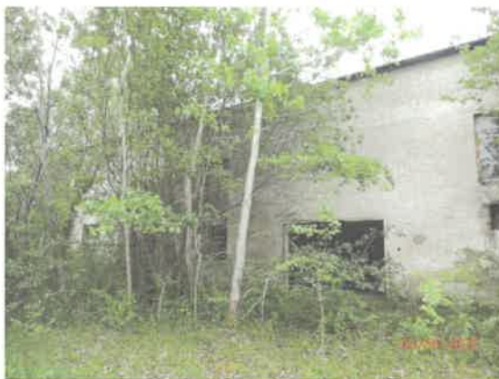
Pohľad na kotolňu zo severnej strany
