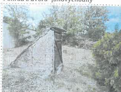
Podzemná pivnica na p. č. 67
