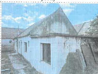
Pohľad z dvora- severovýchodný
