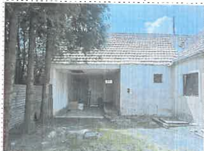
Pohľad z dvora- severovýchodný
