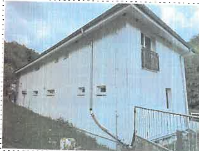
Severozápadný pohľad čiastočný
