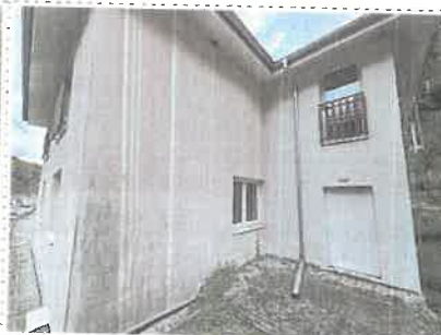
Severovýchodný pohľad čiastočný
