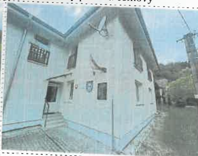
Pohľad na vstup do b. domu z JV strany
