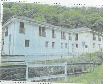
Juhovýchodný pohľad celkový
