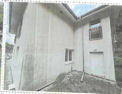
Severovýchodný pohľad čiastočný
