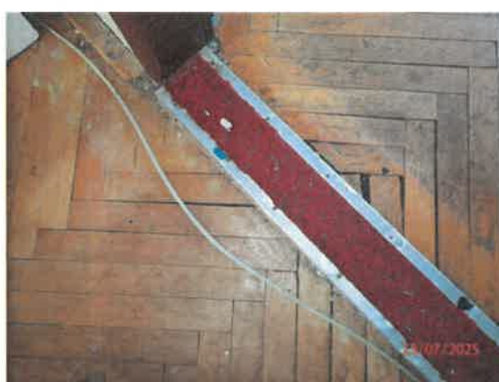
Detail podlahy izby
