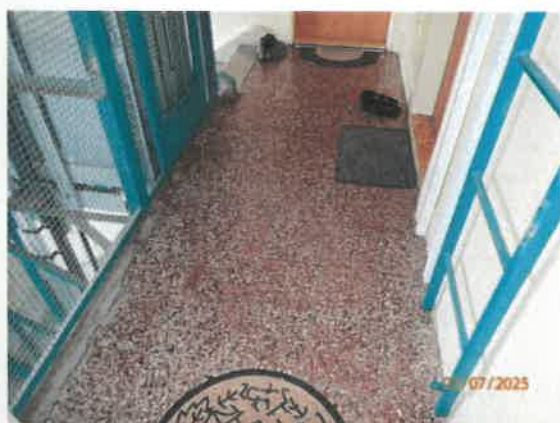
Chodba pred bytom na 6.poschodí
