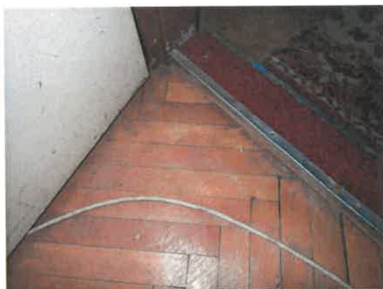
Detail podlahy izby
