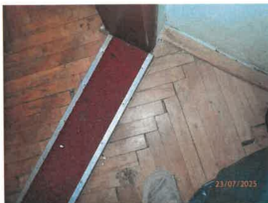
Detail podlahy izby
