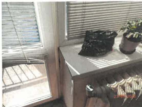
Vchod na balkón z izby
