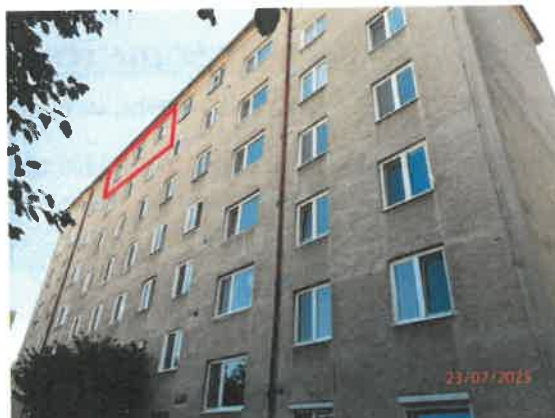
Pohľad na bytový dom z východnej strany
