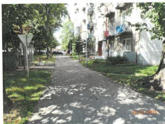
Nádvorie na západnej strane domu
