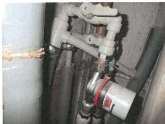
Inštalčné jadro za WC
