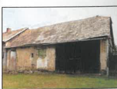
Hosp. budova, p.č. CKN 902/2
