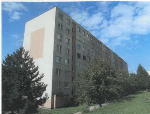
Bytový dom zo severnej strany
