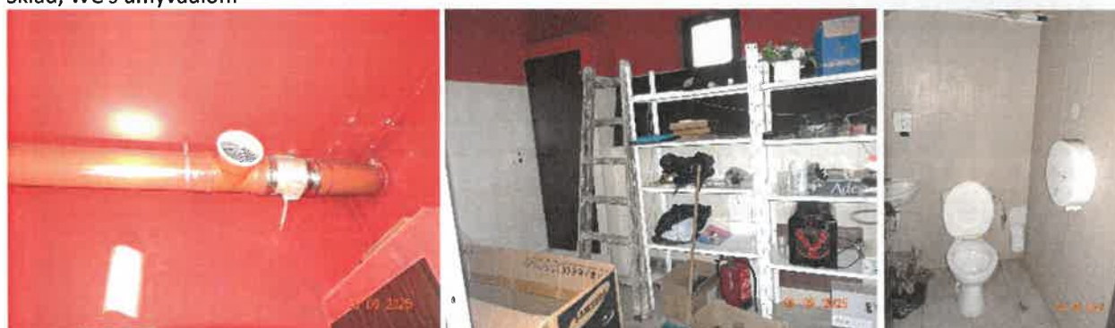
Merania plynu, schody do pivnice, pivnica
