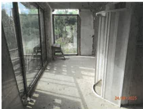
Chodba na I.NP od terasy
