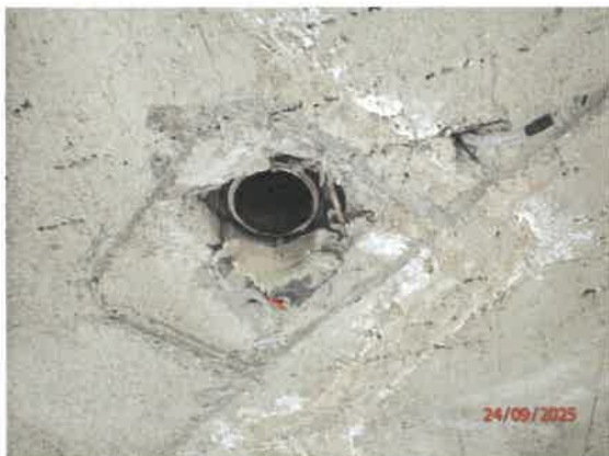
Komínový priechod cez strop v obývačke
