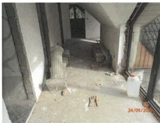
Chodba v podkroví
