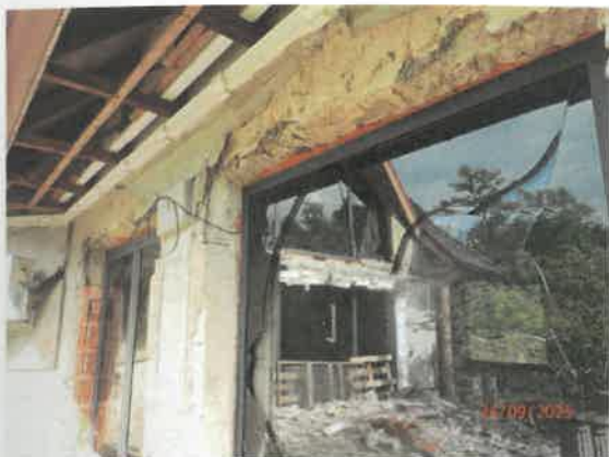
Detail fasády domu na terase
