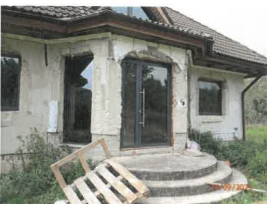
Hlavný vstup do domu od ulice
