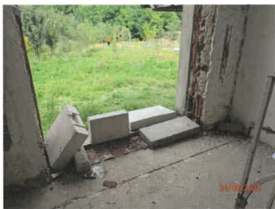
Vybúrané okno na medzipodeste
