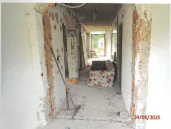
Chodba na I.NP
