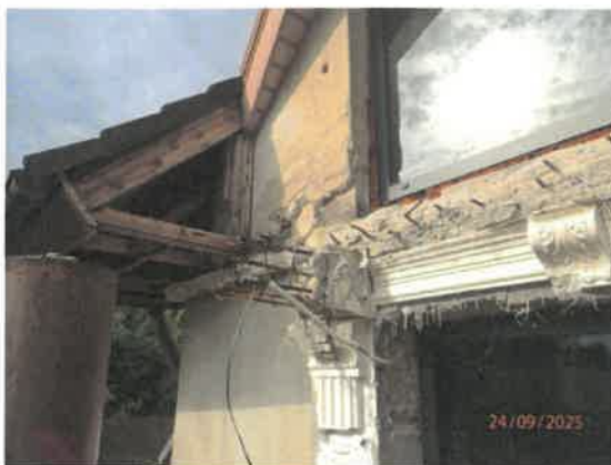
Detail fasády domu na terase
