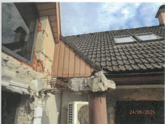
Detail fasády domu na terase
