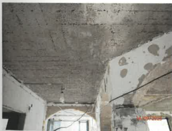
Detail stropu na I.NP – ŽB monolit
