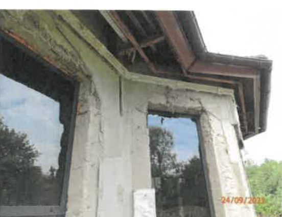
Detail východnej strany domu
