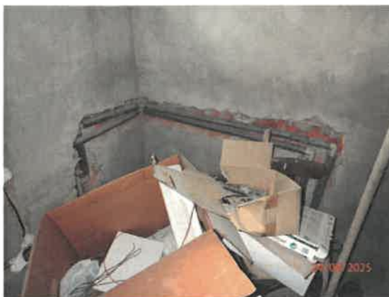
Kúpeľňa vedľa izby na I.NP
