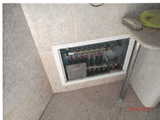
Rozdeľovač ÚK v kúpeľni na I.NP
