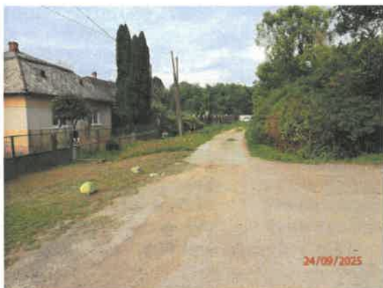
Komunikácia k domu na parc. CKN 502/2
