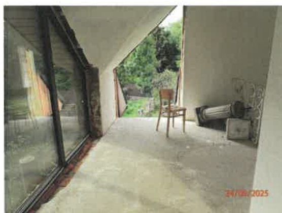
Chodba v podkroví
