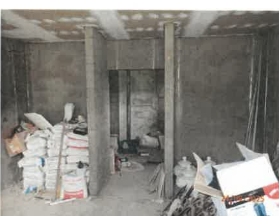
Prechod z izby do kúpeľne na I.NP
