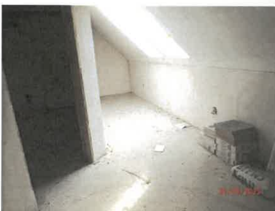
Chodba v podkroví
