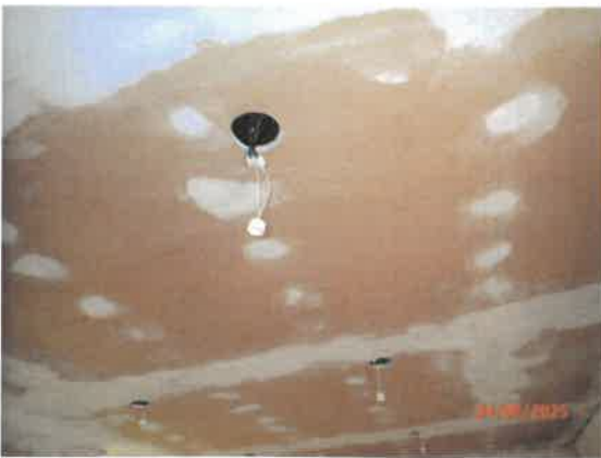
SDK podhľad v podkroví
