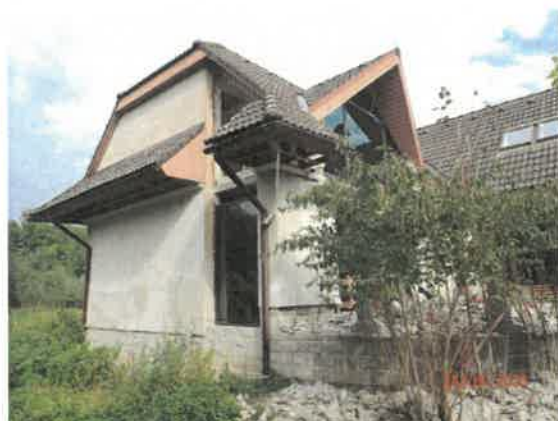
Západná strana domu
