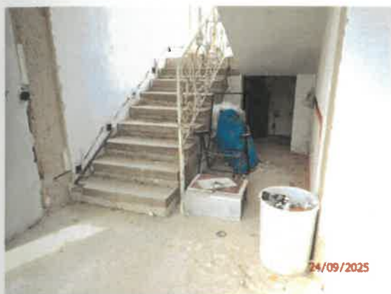
Chodba so schodiskom na I.NP
