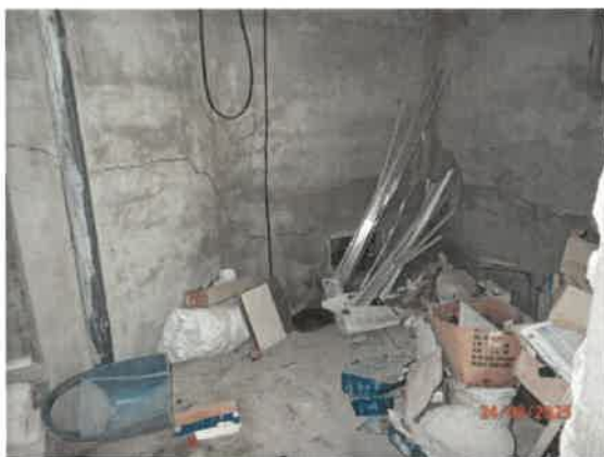
Kúpeľňa vedľa izby na I.NP
