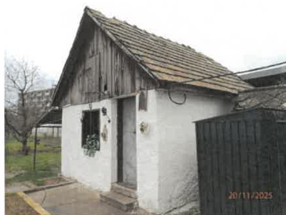
Hospodárska budova za domom
