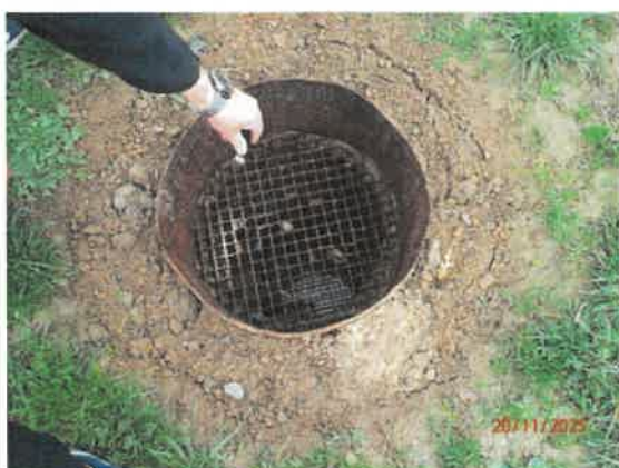
Kanalizačná šachta priebežná vo dvore
