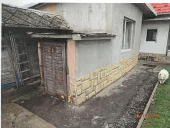
Vstup do suterénu pod domom
