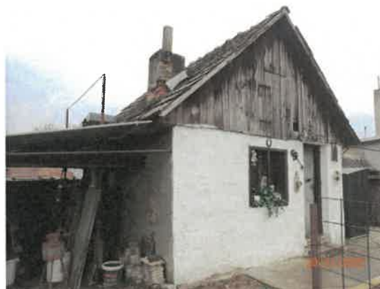
Hospodárska budova za domom
