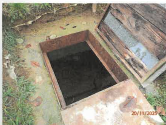
Podzemná pivnica vo dvore
