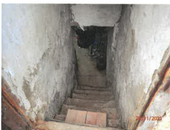
Vstup do suterénu pod domom
