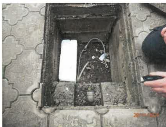
Šachta záhradného vodovodu pri dome
