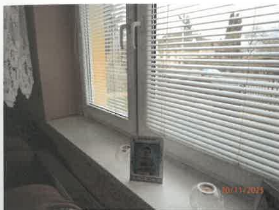
Detail okna druhej prednej izby od ulice
