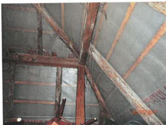
Pôvodný krov s novou krytinou
