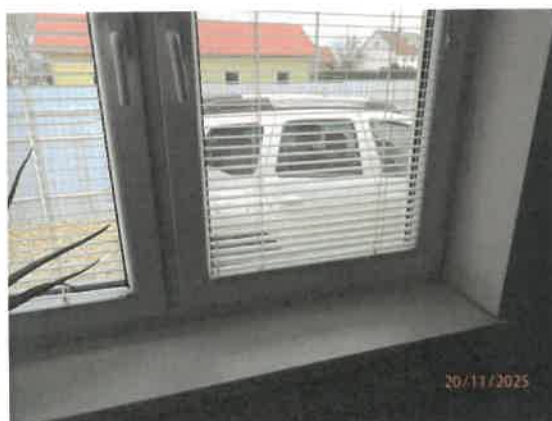
Detail okna bočnej izby
