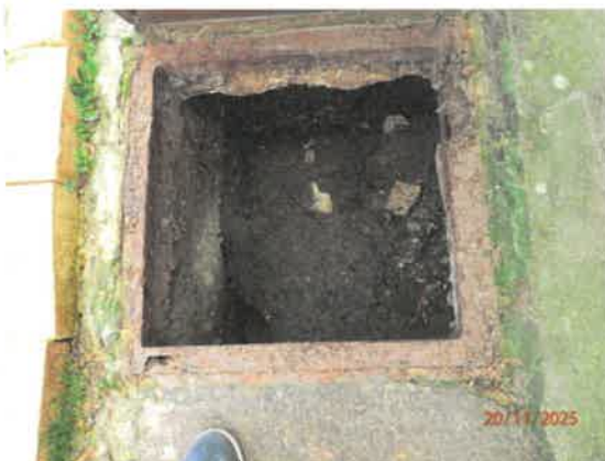
Kanalizačná šachta rohová vo dvore
