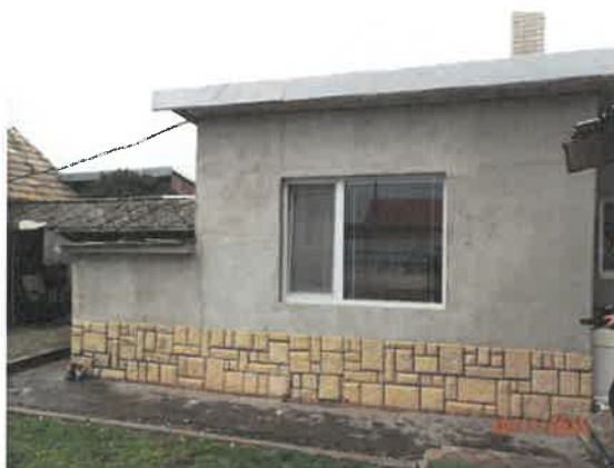
Zadná časť domu z dvora
