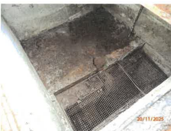
Pohľad do podzemnej pivnice
