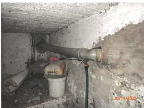
Vyústenie kanalizácie z domu
