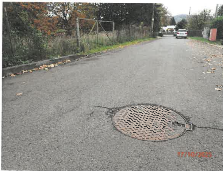
Kanalizačná šachta na ulici pred pozemkom
