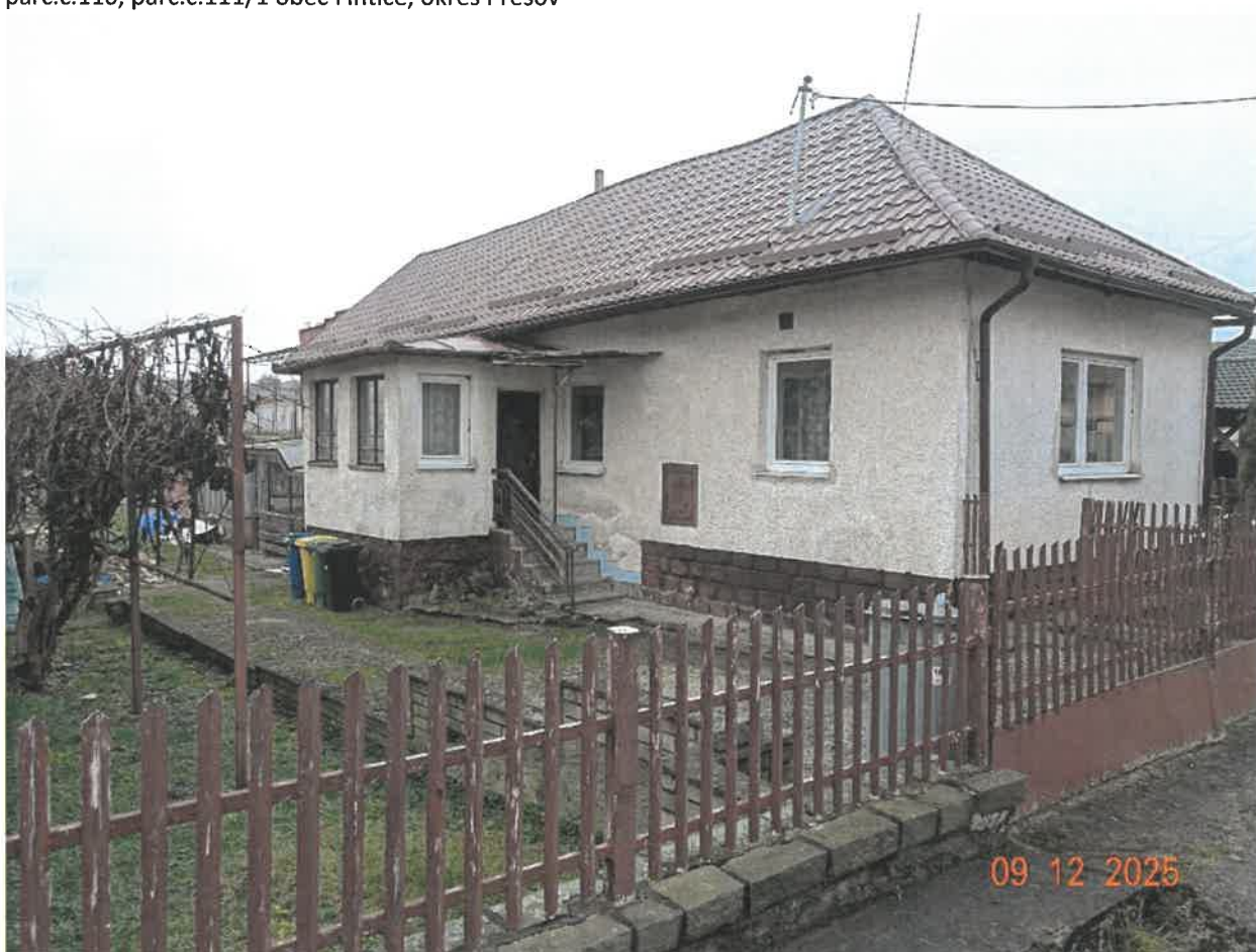
Fotodokumentácia exteriérov z 09.12.2025 vyhotovená znalcom pri obhliadke z ulice - Rodinný dom súp.č.192 na parc.č.110, parc.č.111/1 obec Fintice, okres Prešov
