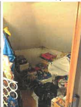
Podkrovie – rozvádzač, odkladací priestor so znakmi zatekania, plesne
