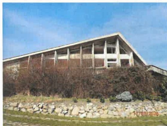
Pohľad na stavbu v smere na SZ
