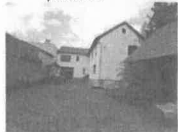
pohľad do dvora
