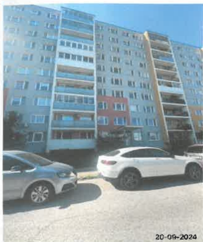
Foto č. 1 Pohľad na BD čelný
