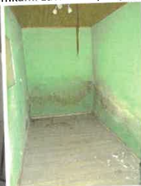
Predná izba a sklad vedľa prednej izby so známkami zavlhnutia, obývacia izba s krbovými kachľami
