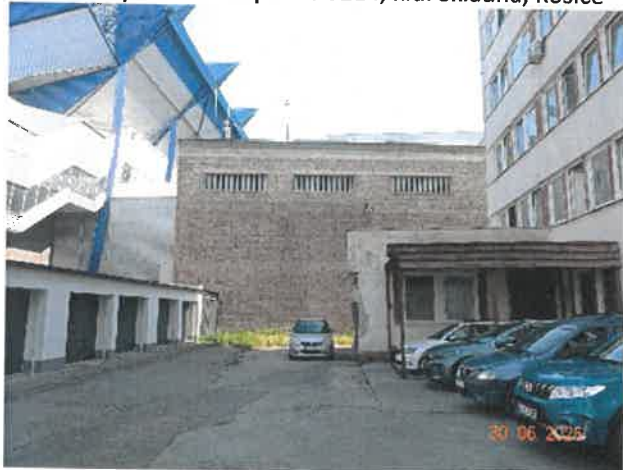
Budova súp.č.1627 na parc.č.3214, k.ú. Skladná, Košice - Juh
