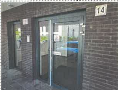
Vchod do domu z východnej strany
