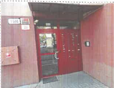
Vstup do domu zo SV strany
